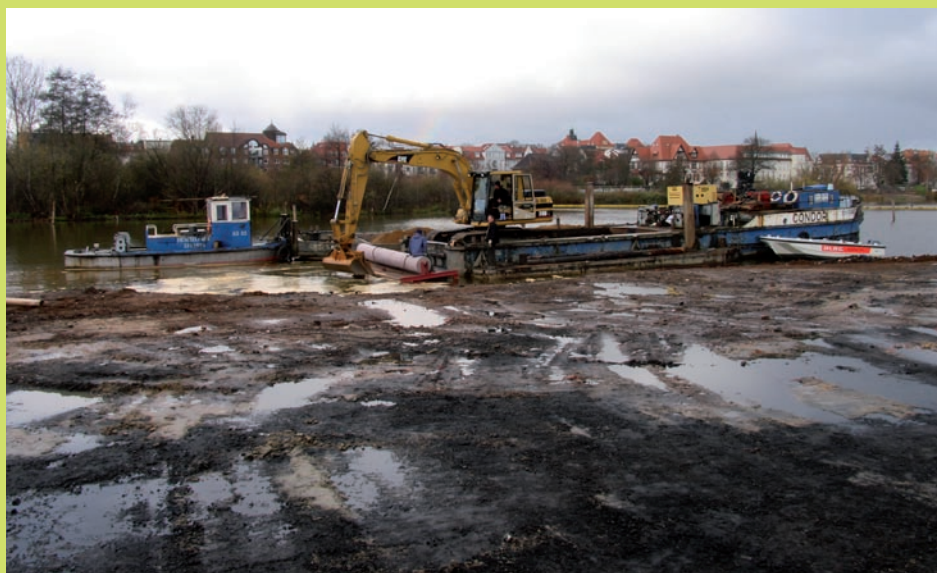
Letzte Bauarbeiten für die Burgseerweiterung
