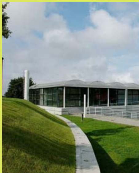
Wasserwerk und Wasserturm Neumühle
